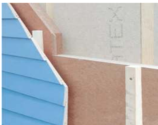
PAVATHERM PLUS op houten ondergronden
