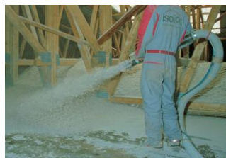
open spuiten op een zoldering met de terminator
